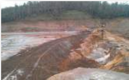
Construção de leira a montante do dique
